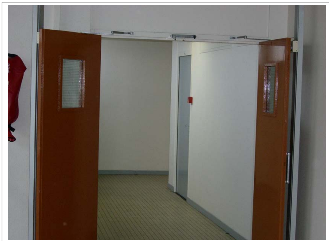
Vue portes de sectionnement coupe-feu avec oculus
