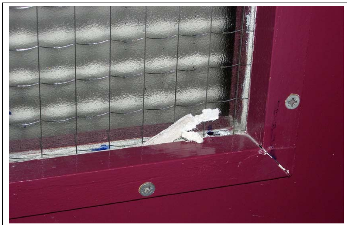
Vue du joint amianté sur oculus de porte : prélèvement n°5
